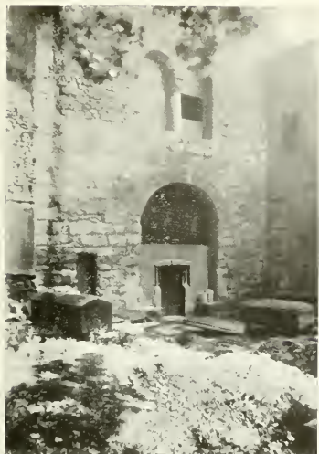
Fig. 1. - Base de la Tour et entrée du côté des anciennes basiliques.
